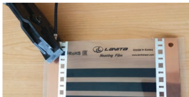
6 Зачистите кабель и вставьте его в наконечник, надежно закрепив при помощи инструмента для обжима.
